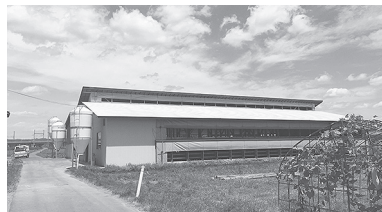
写真 屋根の遮熱塗料の塗装事例(奥州市)
