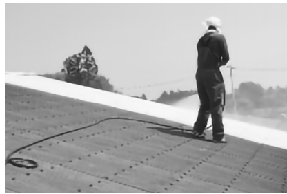
【遮熱】牛舎屋根表への石灰塗布
