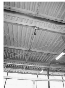
【断熱】屋根裏へのウレタン吹き付け
