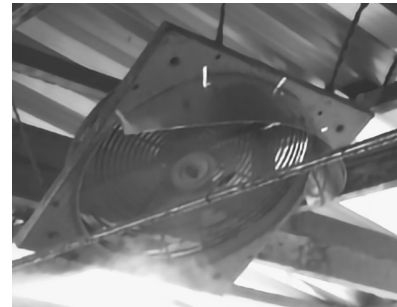
写真2 換気扇へのつばの取り付け
